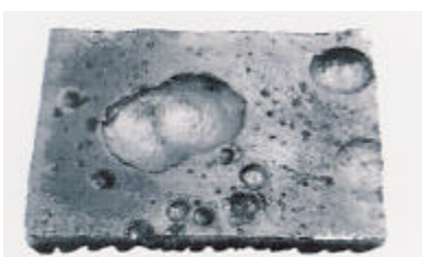
Korrosion durch Algen – Bakterien entstanden
